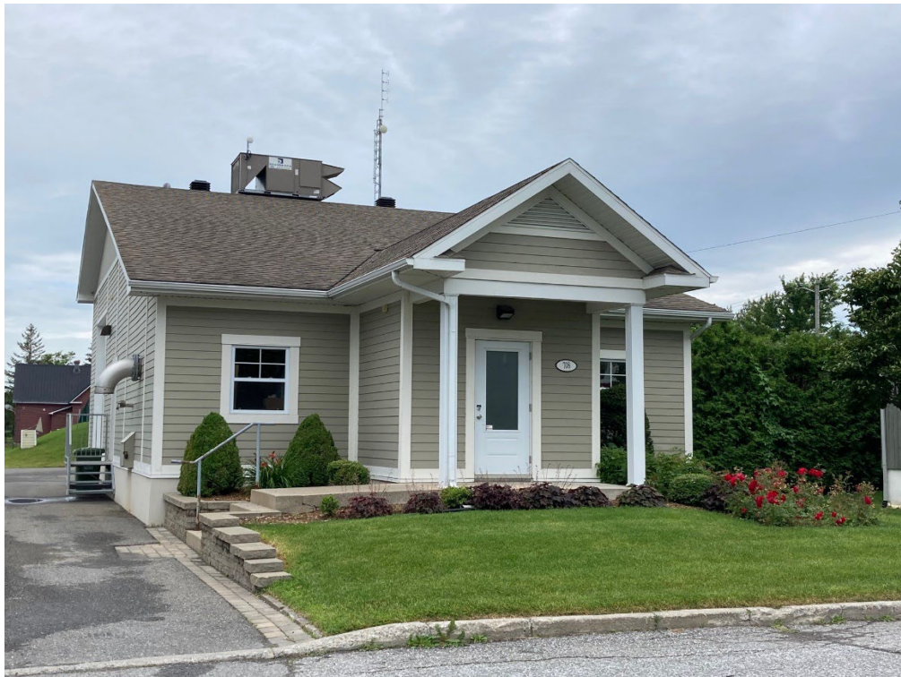
Usine de filtration et distribution d'eau potable de la Municipalité
